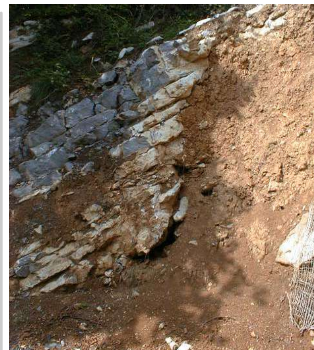
Le rocce calcareo marnose e selcifere della Valle di Fonteno sono sciolte dalle acque superficiali che hanno abbandonato il caratteristico terriccio rosso insolubile delle località carsiche.
